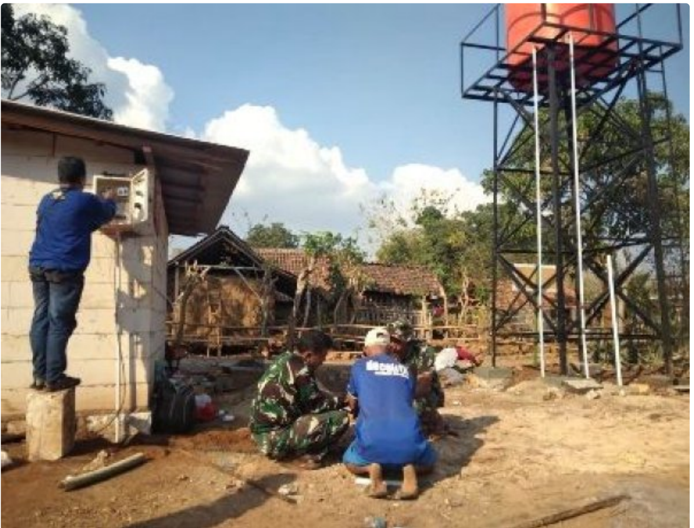
Satgas TMMMD Ke-118 Kodim 0829/Bangkalan saat memasang panel listrik sebagai tenaga pompa pada lokasi pengeboran sumber air.
